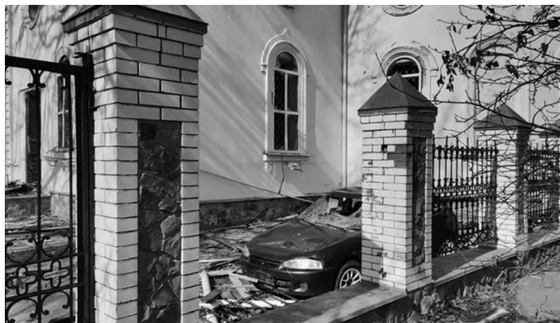
На фотографии храм Троицы Живоначальной в городе Суджа (Курская область), обстрелянный вооруженными силами Украины
